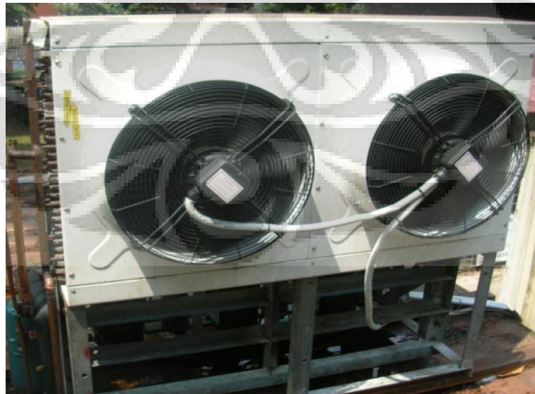
gambar 3.13 kondenser mini ice plant
