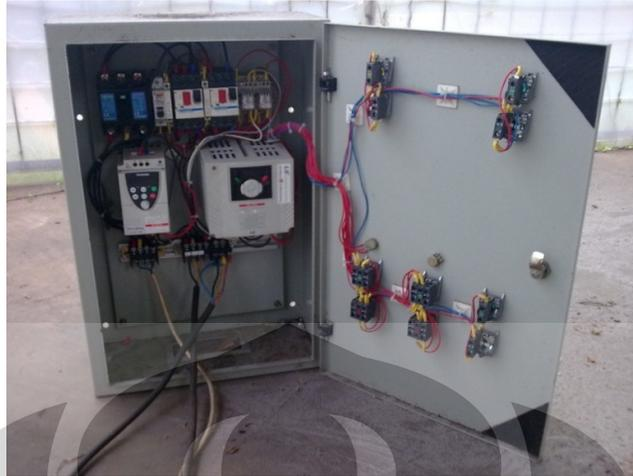
Gambar 3.10 *Control panel* yang Digunakan untuk Feeder dan Blower
