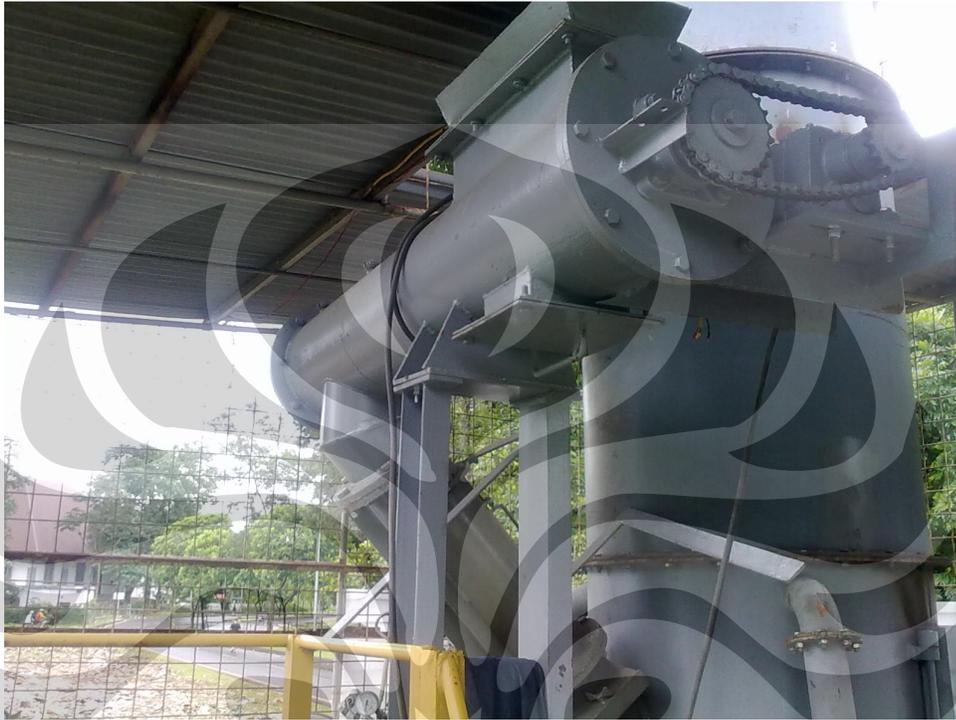
Gambar 3.11 Sistem Feeder pada *Fluidized Bed Combustor* UI
