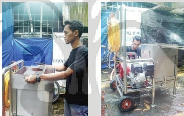
Gambar 4. 17 Menurunkan Reservoir dan Memasangny Pada Dudukan
