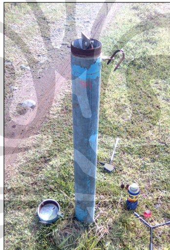
Gambar 2.9. Tes poin pada jalur pipa terpendam
