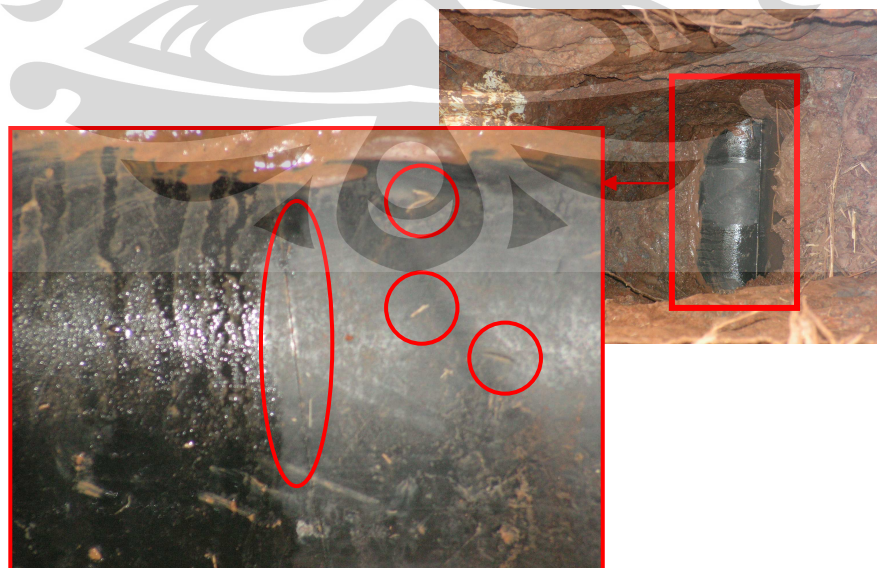
Gambar 4.13. Cacat kecil pada pelapis berkategori 1 dengan %IR drop 1,1
