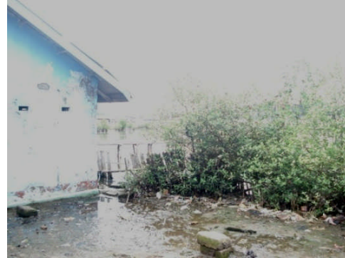
Gambar 4.29. Kondisi Marunda yang selalu tergenang air
