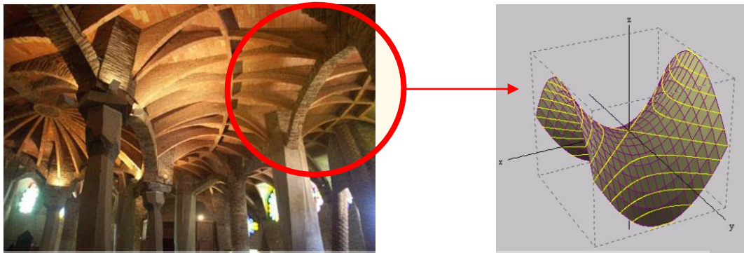
Gambar 4.6 Langit-langit Cript (kiri) Bentuk Hyperbolic paraboloid (kanan) (sumber: Gaudidesigner.com, wikipedia.com)
