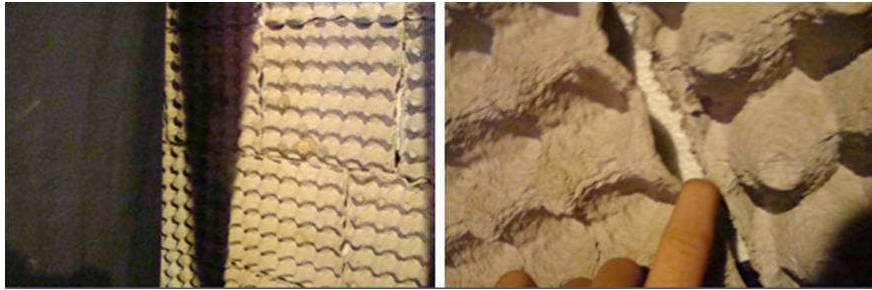
Gambar 4.21 Pemanfaat Wadah Telur sebagai Dinding Peredam
