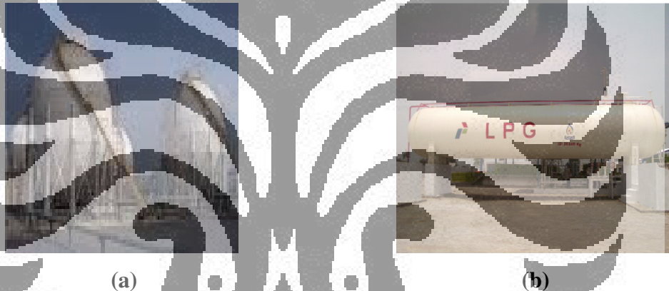
Gambar 2.6 Tangki penimbunan bertekanan yang dirancang dan dikonstruksi berdasarkan peraturan ASME (The American Society of Mechanical Engineers) dan API standard 2510, khusus untuk bejana bertekanan pada (a) Tangki Elpiji bertekanan dalam bentuk spherical tanks dan (b) Sebuah tangki SPPBE.
