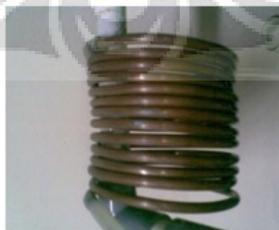
Gambar 3. 4 Pipa Tembaga yang digantungkan pada Pipa PVC
