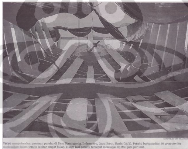
Gambar 1.1 Gading-gading kapal kayu ( Sumber : Kompas, 17 Februari 2009)
