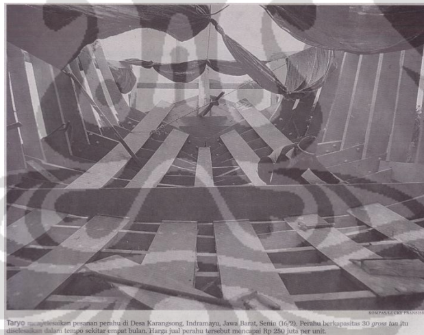
Gambar 1.1 Gading-gading kapal kayu ( Sumber : Kompas, 17 Februari 2009)
