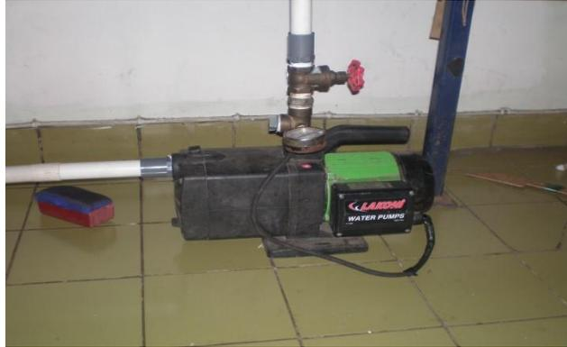
Gambar 3.13. Memasukan Fluida ke dalam tank dengan menggunakan pompa
