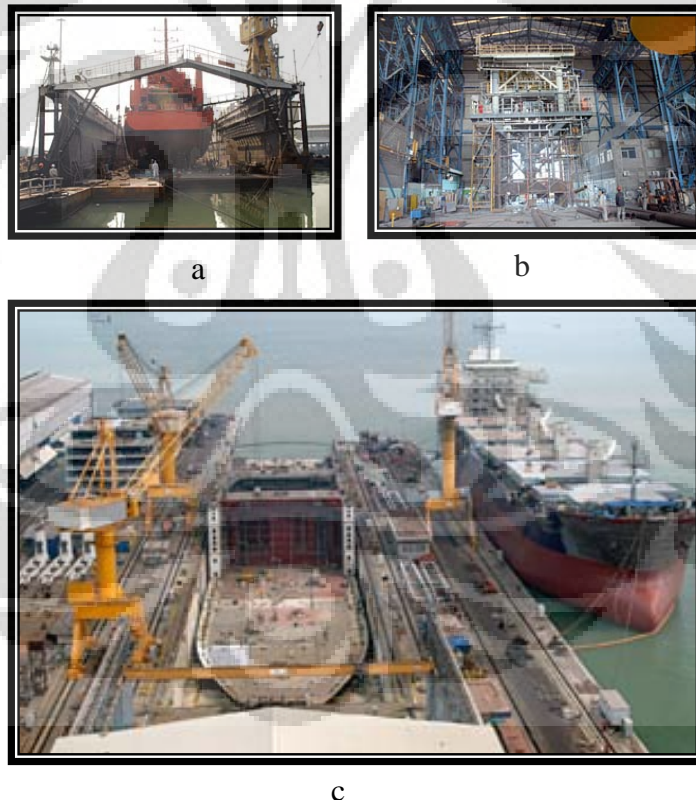
Gambar 4.1 Aktivitas di Galangan Kapal Nasional a. kegiatan perbaikan, b. Kegiatan pembuatan bangunan lepas pantai.offshore, c. Kegiatan pembangunan kapal baru.
