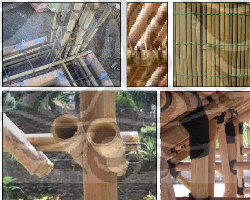
Gbr.4.15. Hubungan struktur bambu pada Community Learning Center Cilacap, Jawa Tengah (Sumber: http://mangroveactionproject.org )
