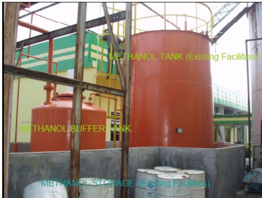
Pabrik Biodiesel PT. Ganesha Energy Produksi 6000 Ton/tahun
