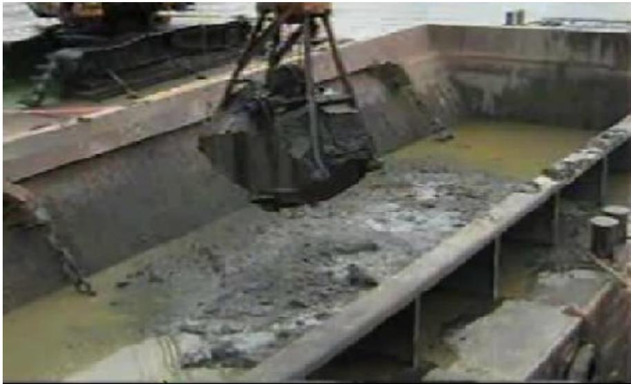
Gambar 4.6 Proses Pengumpulan Lumpur Pada Hoper Barge
