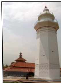
Menara Masjid Agung Banten (Abad ke-17 M)
