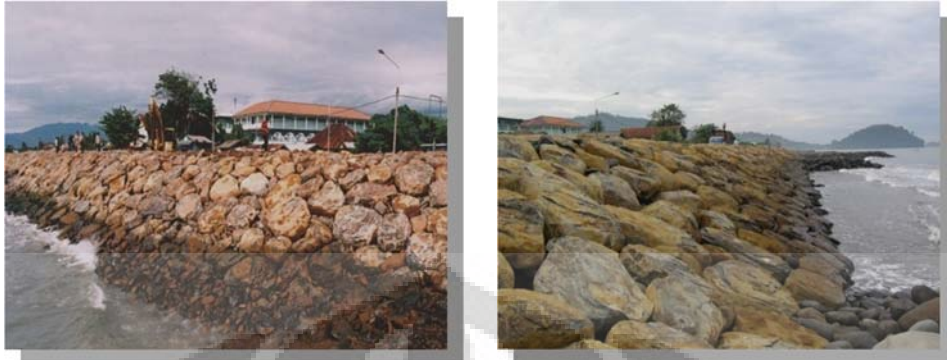
Gambar 24. Sea Wall yang ada pada Kawasan Pesisir pantai Kecamatan Padang Utara dan Padang Barat sepanjang 2.435 m'
