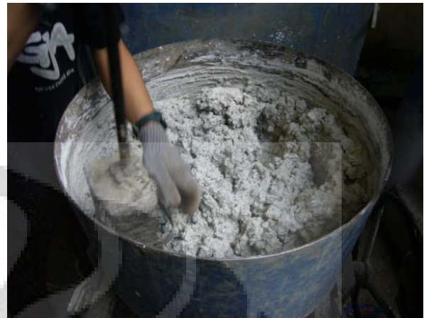
2. Mixer Campuran Beton (Pengadukan)
