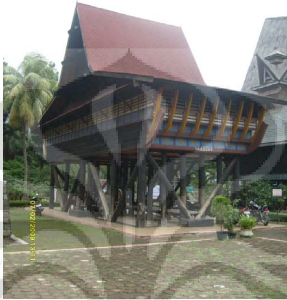
Gambar 3.3.9 Struktur dengan bracing diagonal pada Rumah Tradisional Nias
