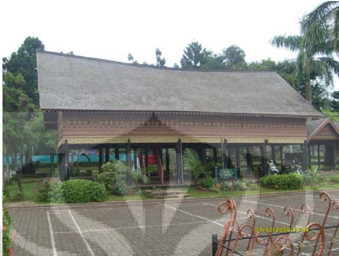
Gambar 3.3.7 Struktur tanpa bracing pada Rumah Tradisional Aceh
