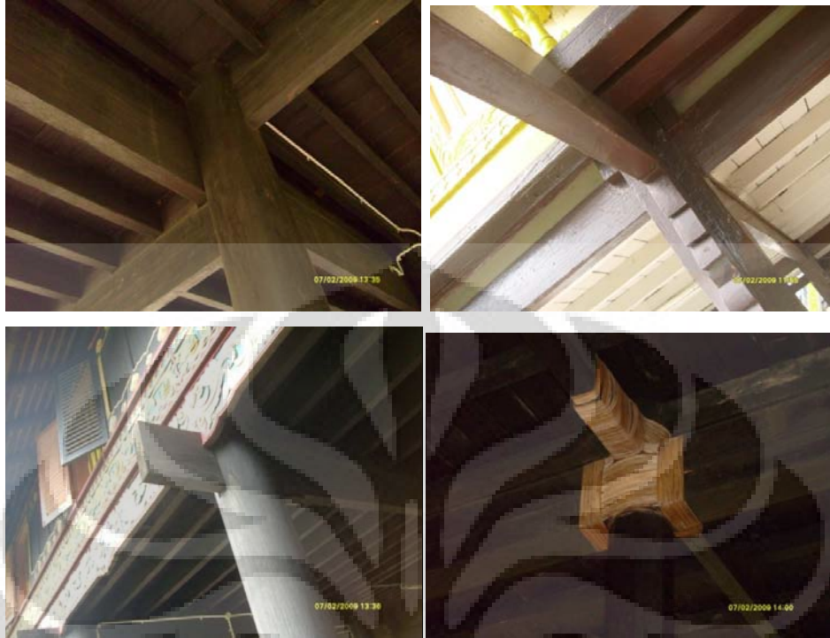
Gambar 3.3.10 Beberapa sambungan pada replika rumah tradisional
