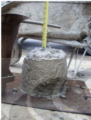
Pengujian slump beton proyek D (slump : 12 cm)
