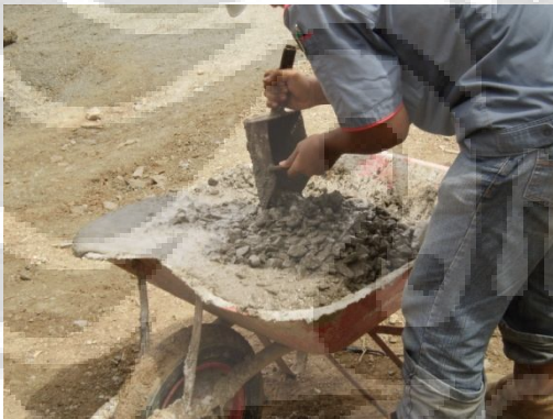
Pencampuran beton segar sebelum dimasukkan kedalam bekisting
