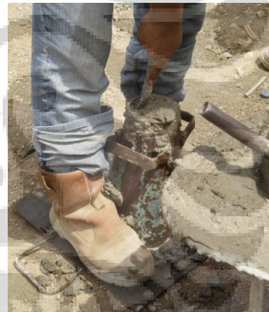
Pengujian slump dengan besi pengaduk
