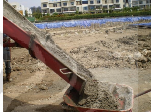
Penuangan beton segar dari molen ke gerobak
