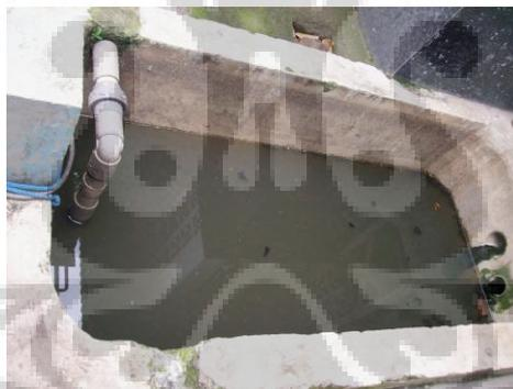
Gambar 4.5 Bak Lumpur (*Sludge Collector*)
