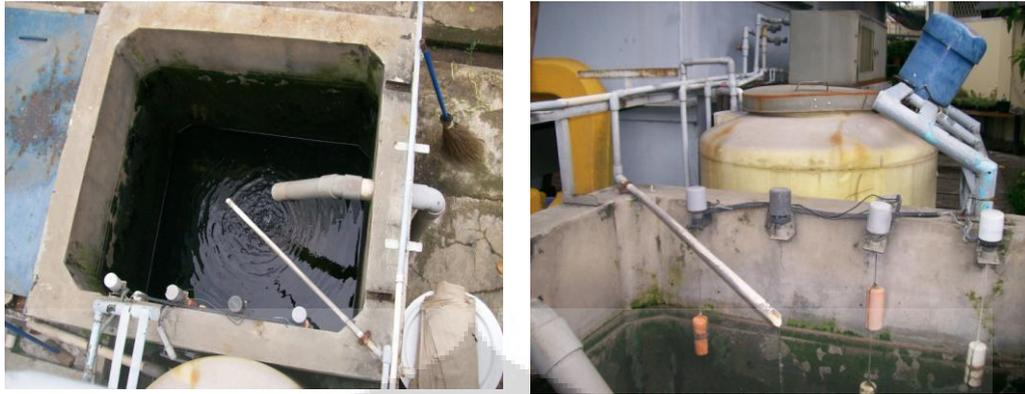
Gambar 4.7 Unit Disinfeksi (kiri) dan Tangki Kimia berisi Disinfektan (kanan)
