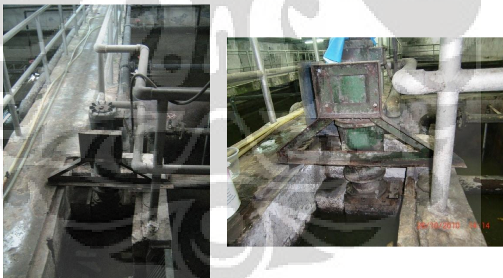
Gambar 4.14 Grinder (Alat Pencacah Limbah Padatan)
