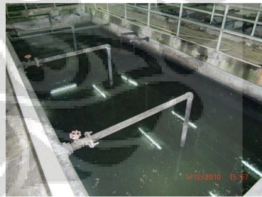
Gambar 4.17 Kondisi Bak Aerasi Saat Blower Beroperasi (kiri) & Tidak Beroperasi (kanan)
