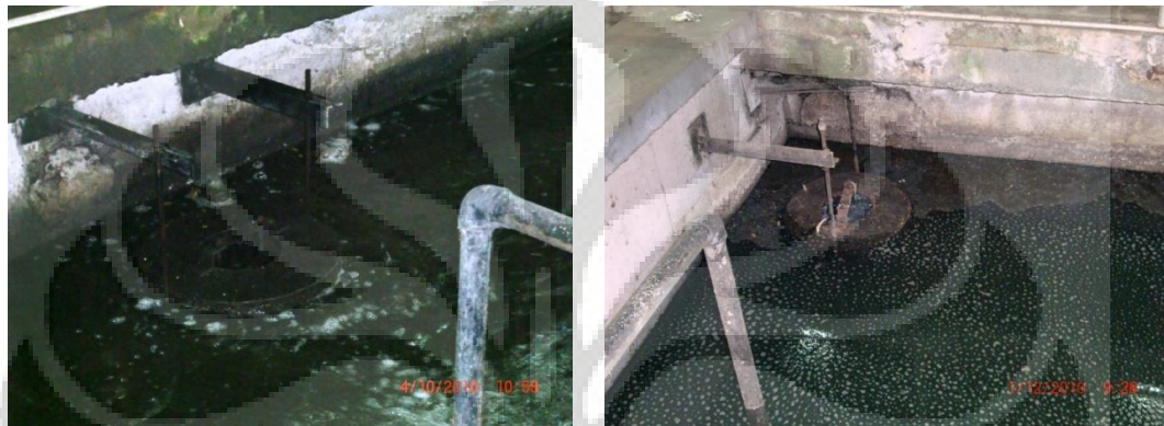
Gambar 4.19 Lubang-Lubang Overflow Di Bak Aerasi
