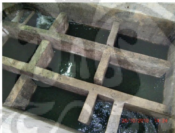
Gambar 4.21 Bak Klorinasi Dengan Baffle
