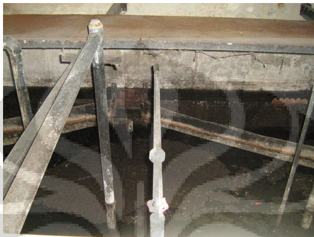
Gambar 4.20 Lumpur Yang Terapung Di Permukaan Bak Sedimentasi
