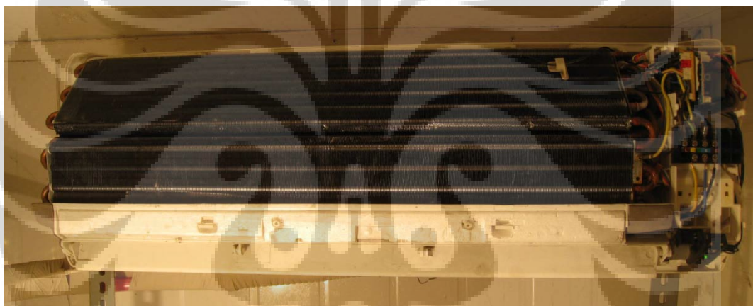
Gambar 3.2 Bagian Evaporator dengan Casing Dilepas
