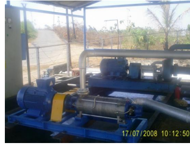
Gambar 1.4. Pompa Centrifugal
