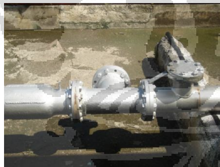
Pembesaran Pipa 6 inci ke 8 inci dari SPU ke PPP Menggung
