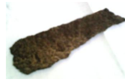
Gambar 3.9. Terkikisnya bagian permukaan pipa bagian luar.
