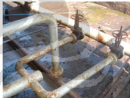
Pipa Masuk dan Keluar Pompa
