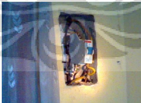
**Gambar 2.12 Kondisi sekering pada PHB yang kurang bagus.**
