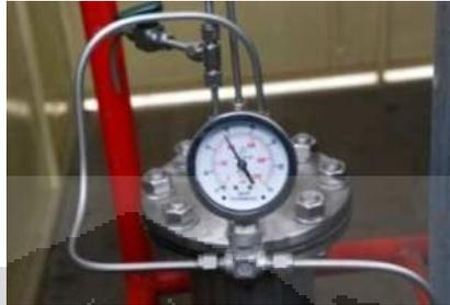
**Gambar 4.12** Pipa dan *Pressure Gauge* yang digunakan
