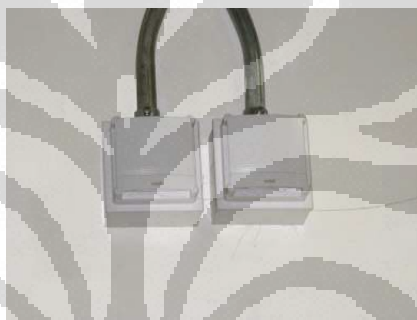
Gambar 3.6 Sensor temperatur dan humidity chiller yang diletakkan di ruang produksi
