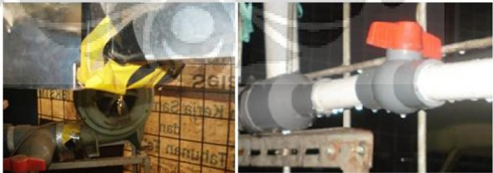
**Gambar 3.21** Kebocoran air pada instalasi pipa dan fabrikasi alat
