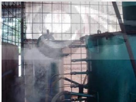
**Gambar 3.19** *Feeding Door* Lama dan Kebocoran yang Terjadi
