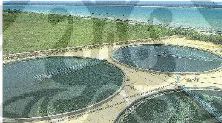
Gambar 2. 7. Fotobioreaktor Terbuka untuk Pemiakan Chlorella vulgaris .
