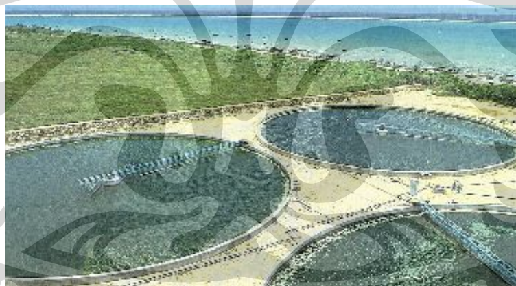
Gambar 2.5. Fotobioreaktor Terbuka untuk Pemiakan Chlorella vulgaris .
