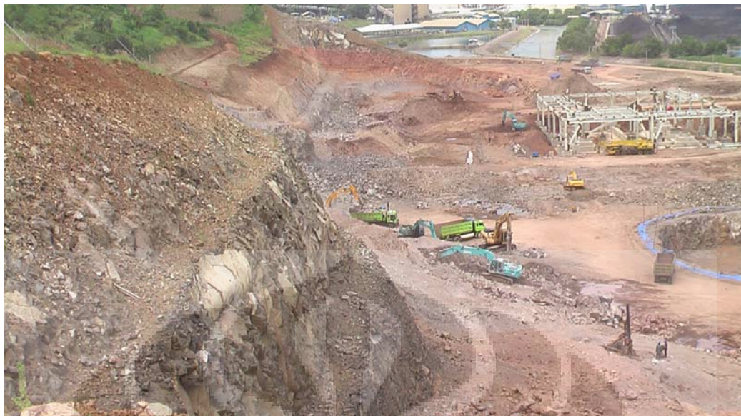
Gambar 3.2 Struktur Tanah Proyek PLTU X
