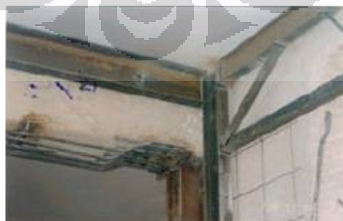
Gambar 2.20. Perkuatan pada Balok dan Pelat
