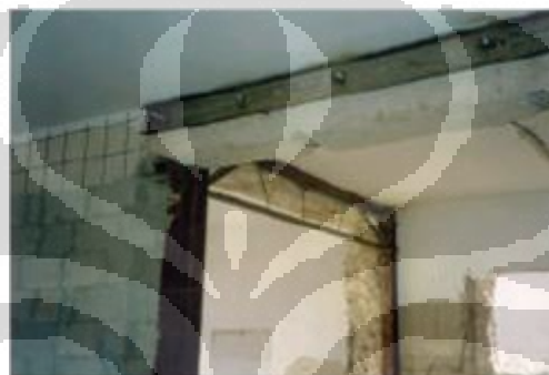
Gambar 2.22. Perbaikan dan Perkuatan dengan Pelat Baja
