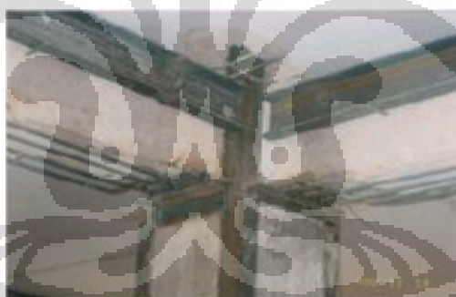
Gambar 2.19. Perkuatan pada Balok, Kolom dan Pelat
