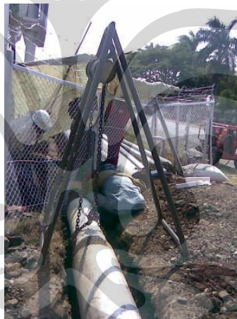
Gambar 3. 10 Proses Penggantian Pipa Baru
