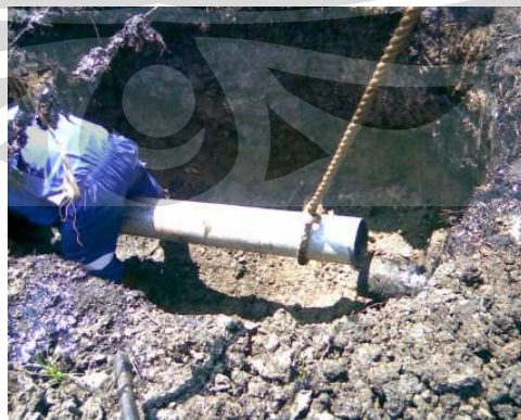
Gambar 3. 9 Proses Penyisipan Pipa
