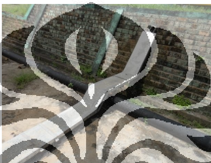
Gambar 6.13 Proteksi Kabel
