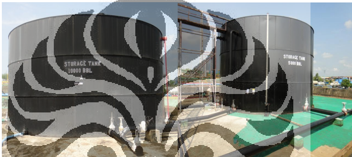
Gambar 6.1 Tangki Penyimpanan minyak mentah 10.000 dan 5.000 bbls
