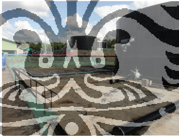
Gambar 6.3 Tanggul dan saluran pengumpul pengendali tumpahan
