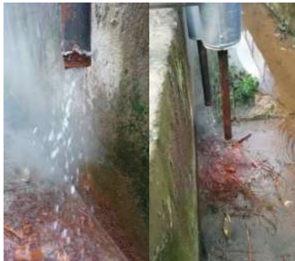
Gambar 5. Pembuangan Limbah cair PLTP Ulumbu
