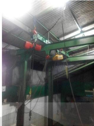
**Gambar 7.4 Hook Tersambung dengan Katrol pada Rail System**
