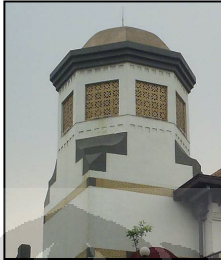
Foto4.5 Menara Gedung Kunstkring Dok: Alin Musfiroh Arum 2009
