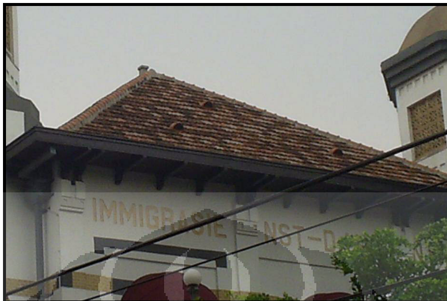
Foto 4.6 Atap Gedung Kunstkring
