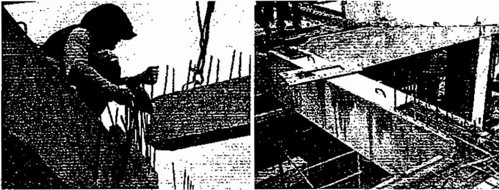
Gambar 5.15. Sambungan Balok Anak
