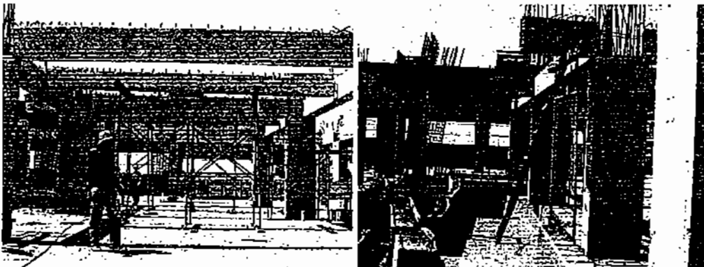
Gambar 5.11. Shoring Balok
