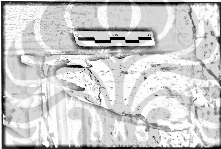
Foto 2.14. Segitiga beton bertulang pada bentangan baja (Dok: Muhamad Oksy, 2009)
