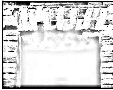
Foto 2.7. Konstruksi busur landai pada jendela (Dok: Muhamad Oksy, 2009)
