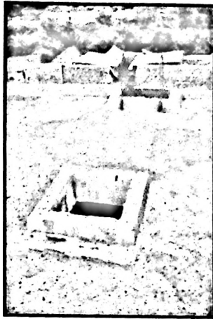
Foto 3.8. Lubang pada bagian atas tandonan tertutup (Dok: Muhamad Oksy, 2009)
