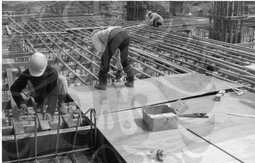
**Gambar 4.4 Pekerjaan Pemasangan Bekisting Flat Slap**
