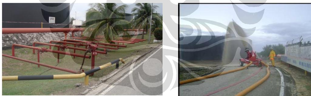
**Gambar 6.1. Manifold dan Peralatan Pemadaman (*terminator*)**
