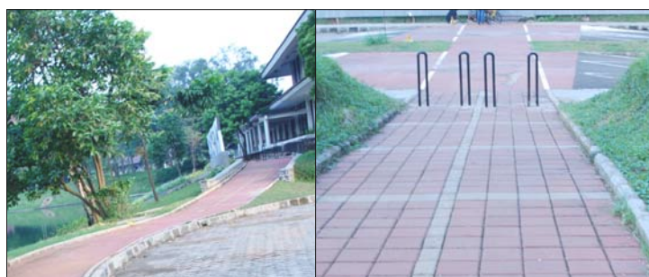
Gambar 6.2 Besi Lintasan atau Separator
