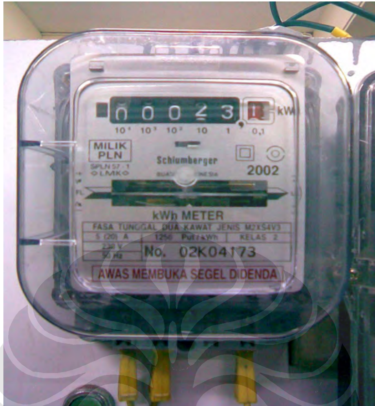
Gambar 3.7 KWh-meter satu fasa untuk fasa 2
