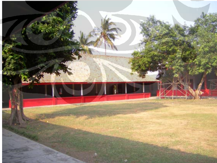
Foto 32. Bangunan tambahan sisi Utara (Nandita Erisca, 2008)
