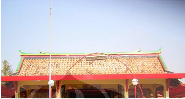
Foto 24. Atap bangunan utama (tampak depan) (Tommy Pratomo, 2007)
