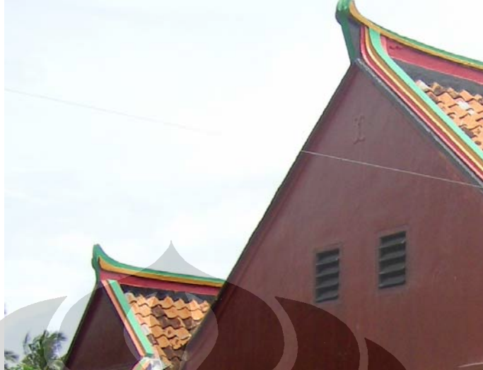
Foto 26. Bagian atap bangunan utama (tampak samping) (Tommy Pratomo, 2008)
