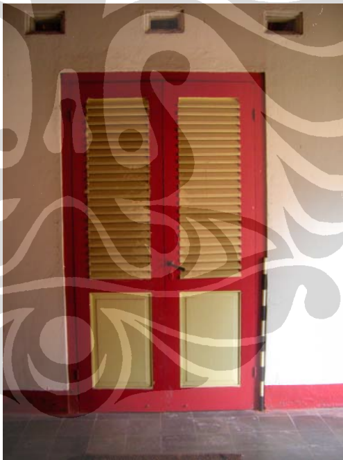
Foto 23. Pintu penghubung dengan Ruang Jin Ji Le Thie Sin (Sumber: Nandita Erisca, 2008)
