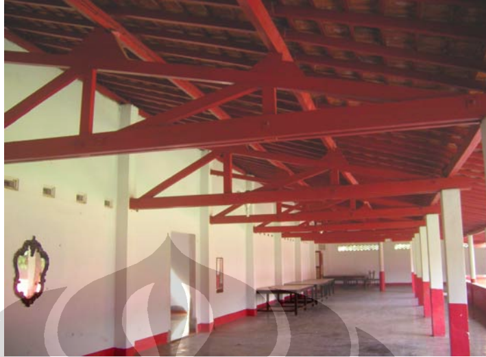
Foto 35. Bagian dalam atap bangunan tambahan sisi Barat (Sumber: Nandita Erisca, 2008)
