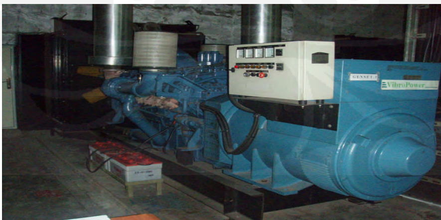
Gambar 3.2 Generator AC 937,5kVA
