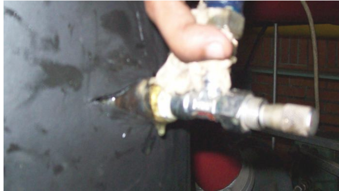
Gambar 3.11 katup ekspansi
