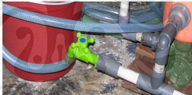
Gambar 3.18 Katup Pengatur Tekanan Air
