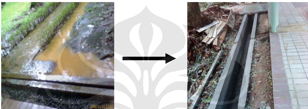
Gambar 6.1 Contoh Perbaikan Saluran
