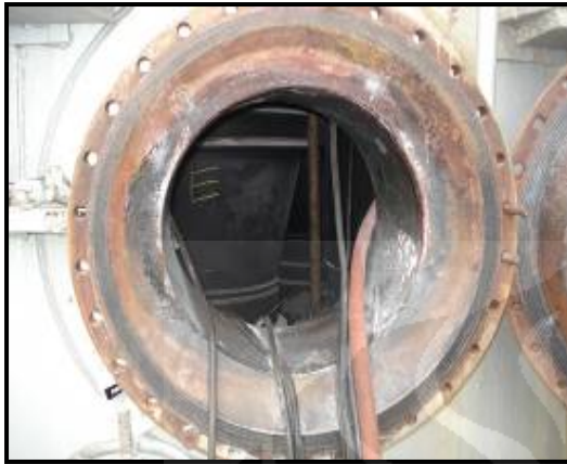
Gambar 4.1. Manhole salah satu access menuju lokasi area cyclone
