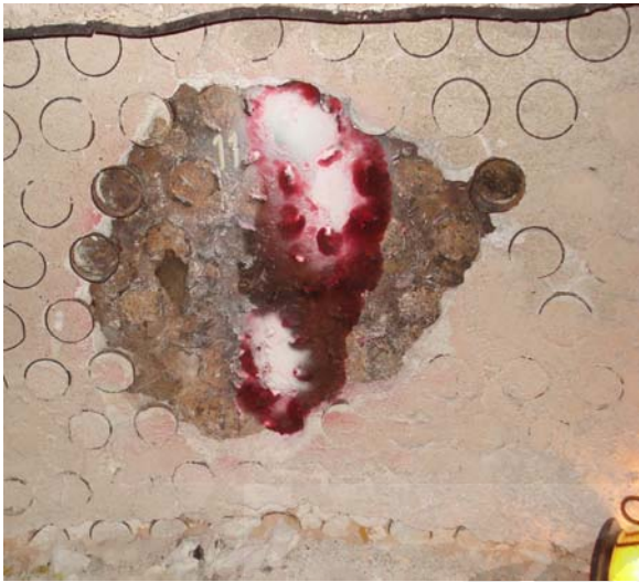
Titik No. 11 ( 324^\circ/\text{B-C} ) setelah dilakukan Penetrant Test pada lokasi shell plenum lama bagian atas header.
